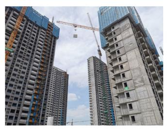
遠洋集團積極推進裝配式建築的實踐,全面推動 在施裝配式項目的提質提效,以及裝配式關鍵技 術的應用研究和專業人才的培養,有效控制和降 低了建造過程中能源資源消耗,同時減少廢棄物 排放和環境污染。相對於現澆建設方式,裝配式 建築可節水約 25%,降低抹灰砂漿用量約 55%, 節約模板木材約 60%,降低施工能耗約 20%,同 時減少 75% 以上的建築垃圾,顯着降低施工粉 塵和噪聲污染,減少碳排放。
